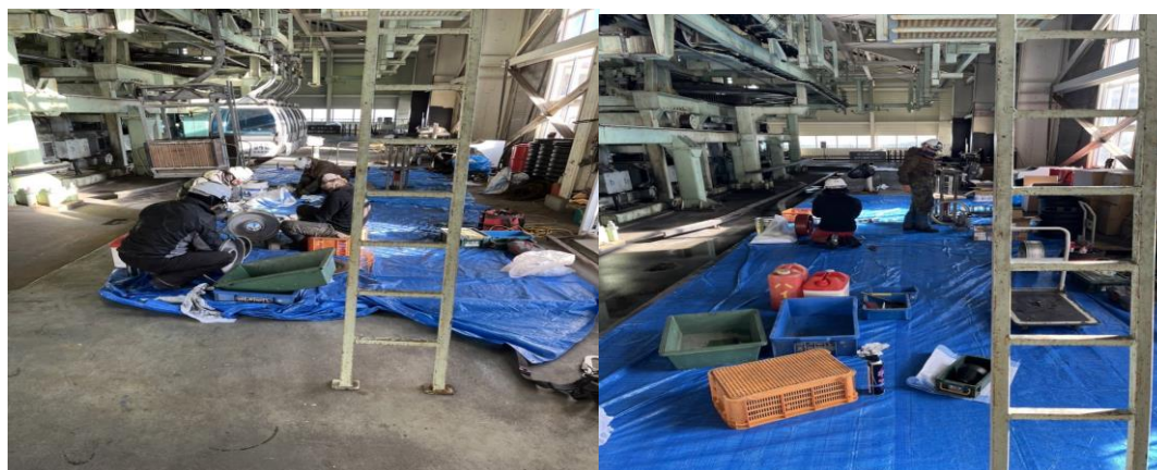
【索輪交換整備】
